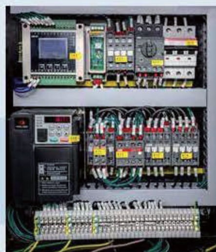
电器元件布局图 Electrical Component Layout
